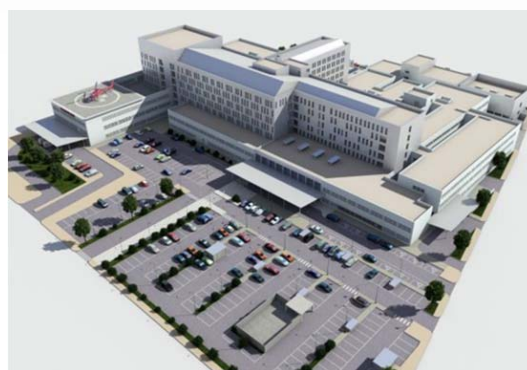
Visión delantera final de obra
