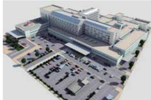
ESTADO FINAL DEL EDIFICIO TRAS LA FASE II. VISIÓN TRASERA-LATERAL
